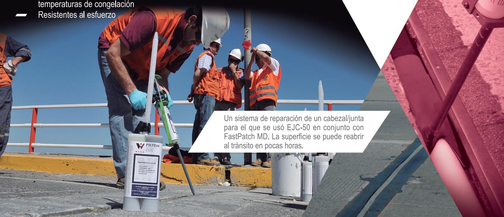
Un sistema de reparación de un cabezal/junta para el que se usó EJC-50 en conjunto con FastPatch MD. La superficie se puede reabrir al tránsito en pocas horas.
